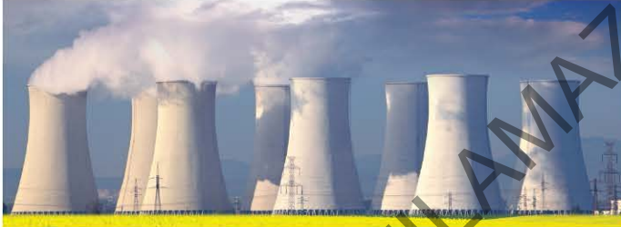
Nükleer enerji santrali
