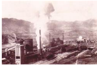
Karabük demir – çelik fabrikası
