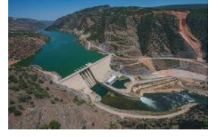
II. Hidroelektrik santrali
