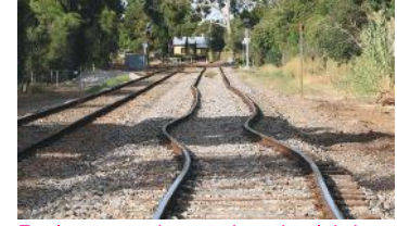
Raylar arasında yeterince boşluk bırakılmadığında, yazın genleşmeden dolayı rayların yapıları bozulur.
